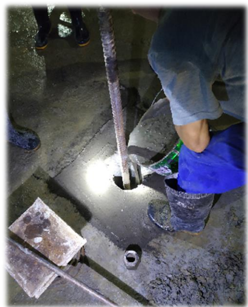
图13-2-5. 抗浮锚杆封孔
