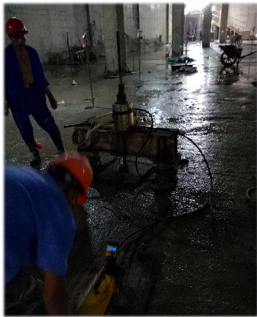
图13-2-7. 抗浮锚杆张拉
