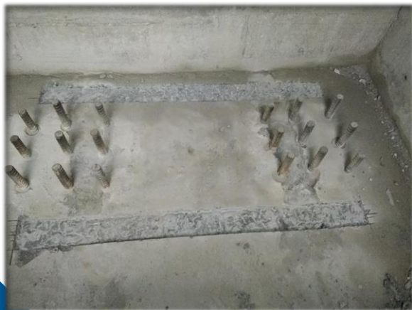
图13-1-1. 反力架锚杆
