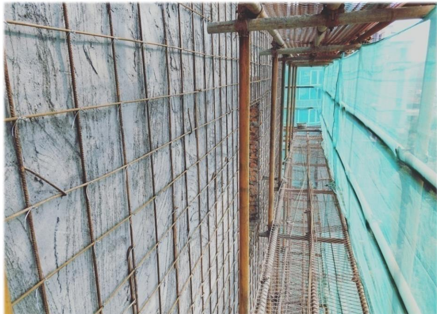
图14-2. 勾缝、粉第一遍、安装钢筋
