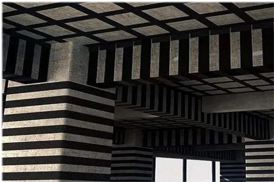
图15-10. 外粘碳纤维布施工
