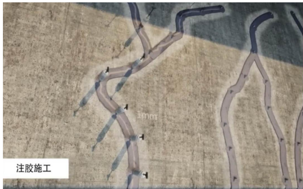
图15-14-2. 混凝土裂缝注胶施工
