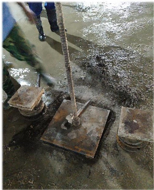
图13-2-6. 抗浮锚杆封孔后加钢板锁锚
