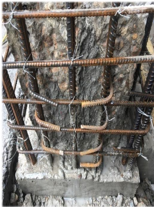
图15-13. 混凝土表面凿毛至露筋施工
