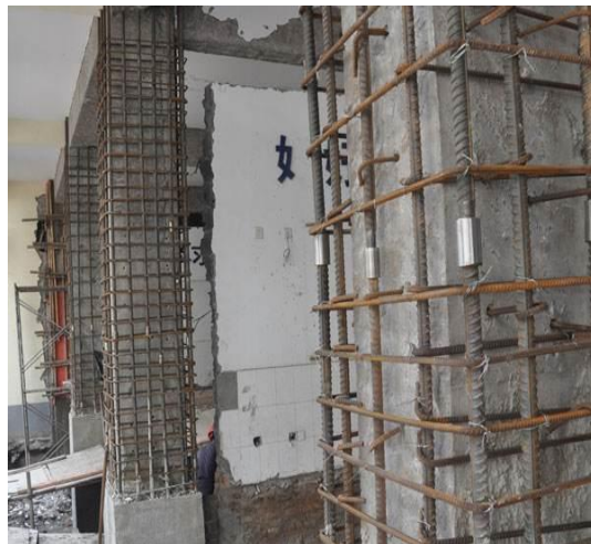
图15-8-1. 混凝土柱截面增大
