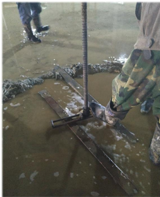
14. 抗浮锚杆注浆
