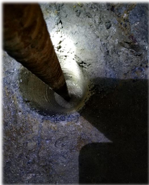
图13-2-5. 抗浮锚杆封孔
