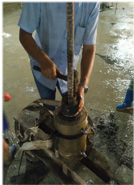
图13-2-9. 抗浮锚杆张拉千斤顶安装
