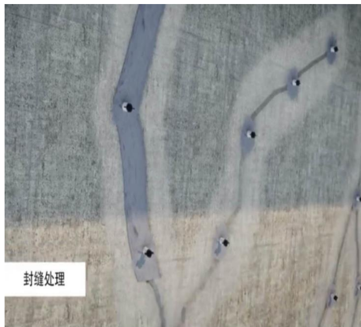
图15-14-1. 混凝土裂缝封闭处理
