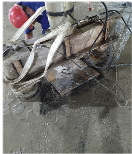
图13-2-8. 抗浮锚杆张拉后锁锚
