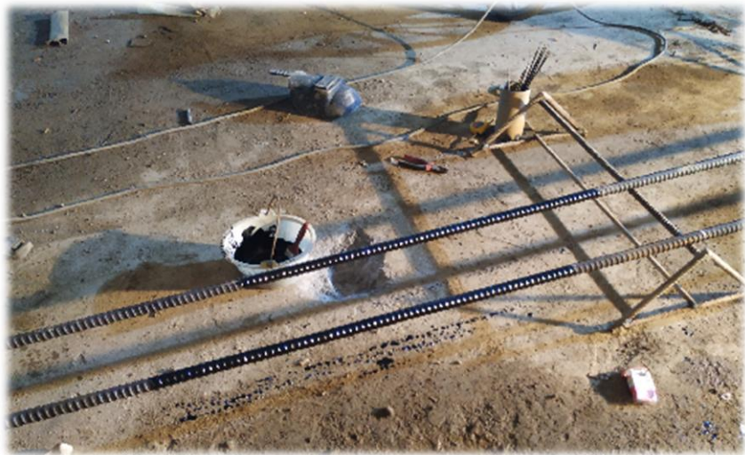
图13-2-2. 锚杆防腐油漆
