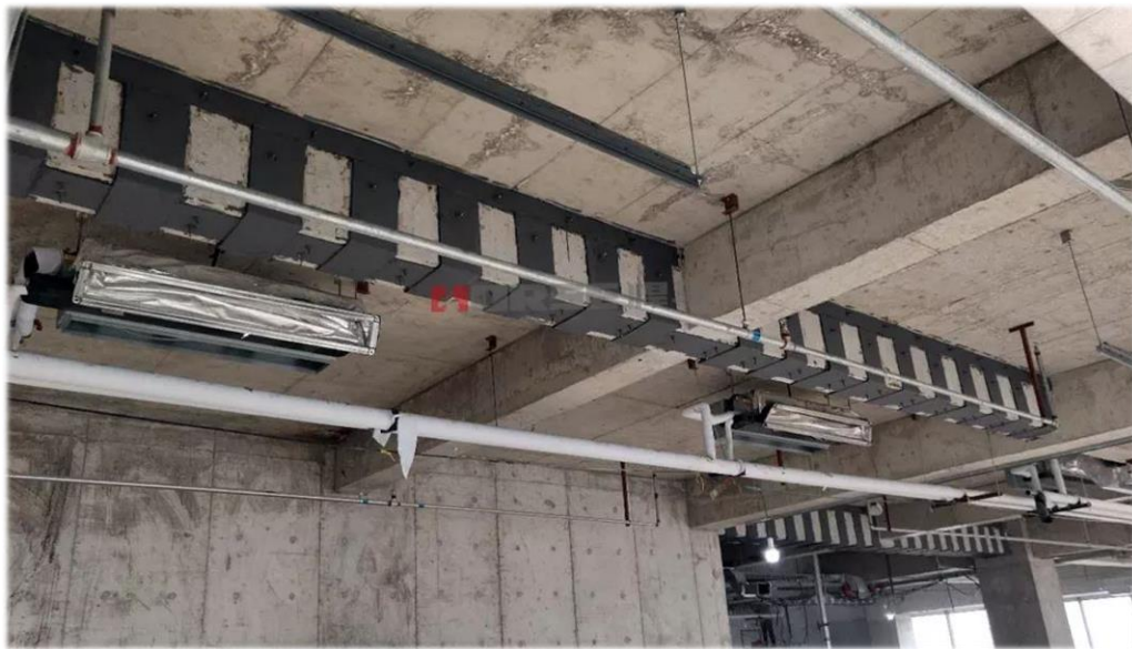
图15-12. 梁粘钢加固施工
