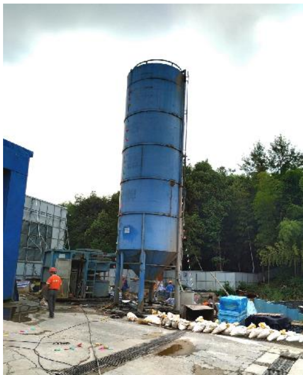
图13-2-16. 注浆设备安装
