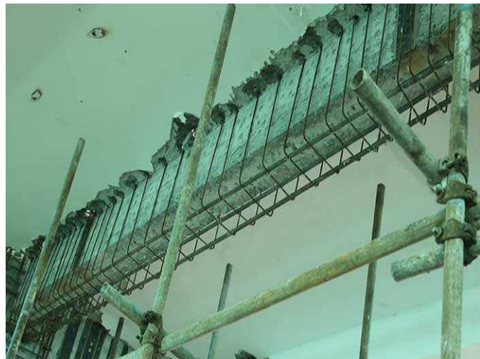
图15-8-2. 混凝土梁截面增大
