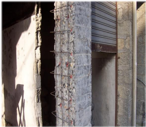
图15-8-1. 混凝土柱截面增大
