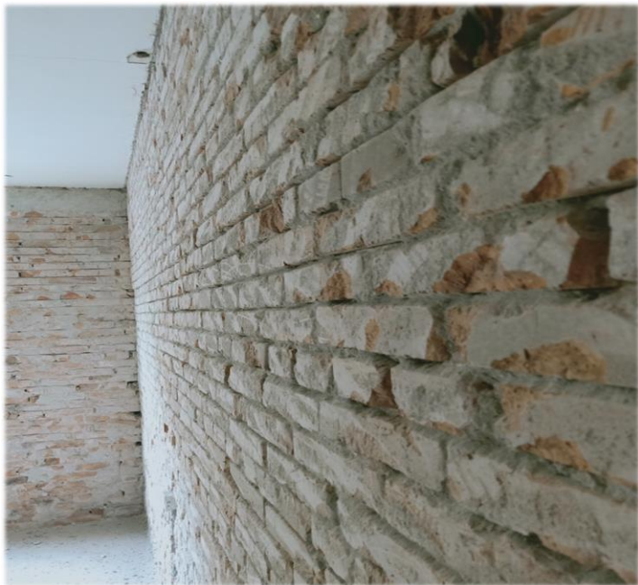
图14-1. 砌体剔灰缝
